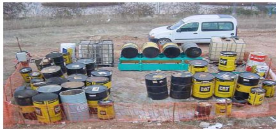
Punto limpio: Almacenamiento de sustancias peligrosas.
