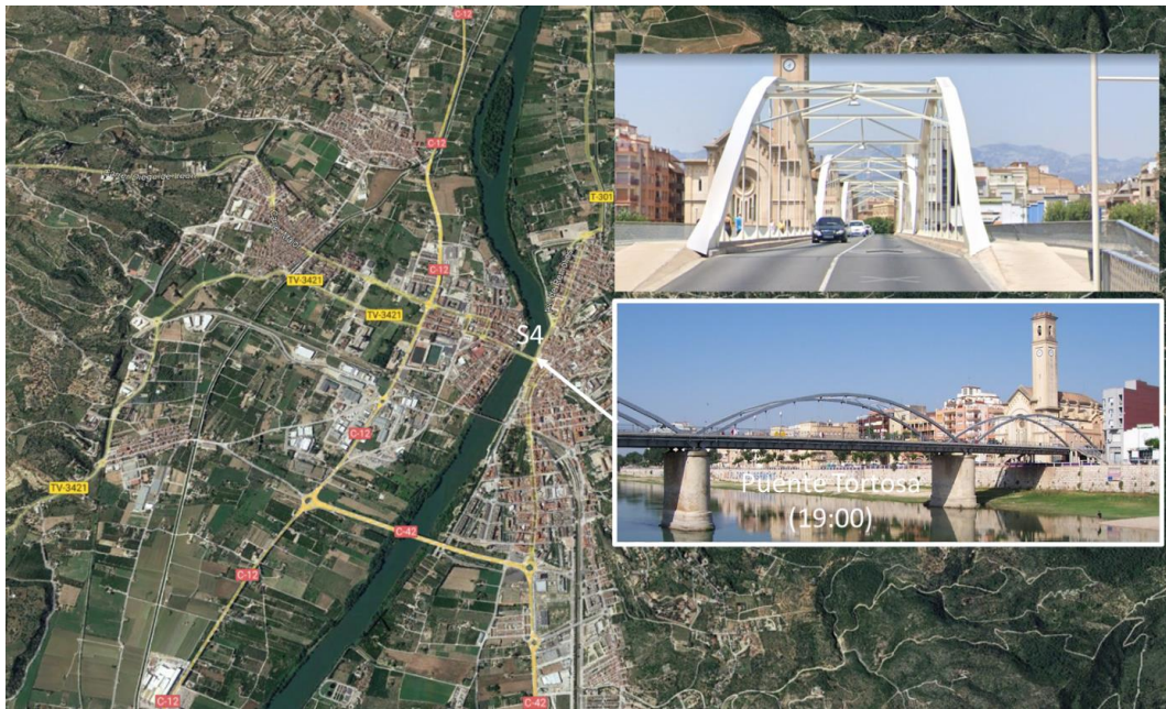
Figura 8. Sección de control S4. Puente de Tortosa.
