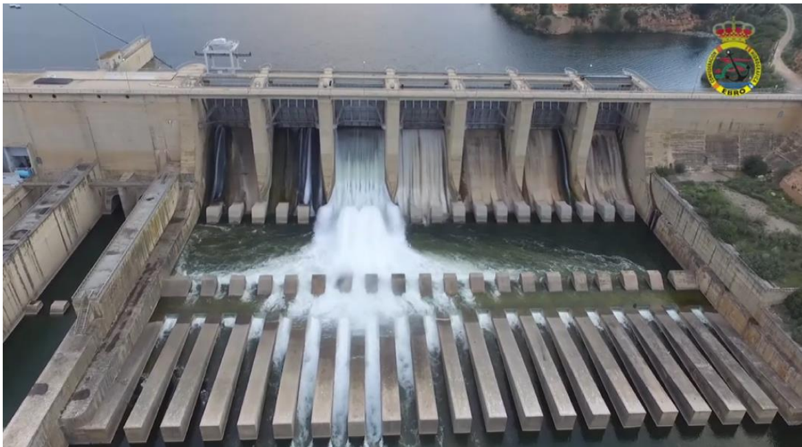
Figura 16. Aliviadero de la presa de Ribarroja durante las maniobras de apertura.
