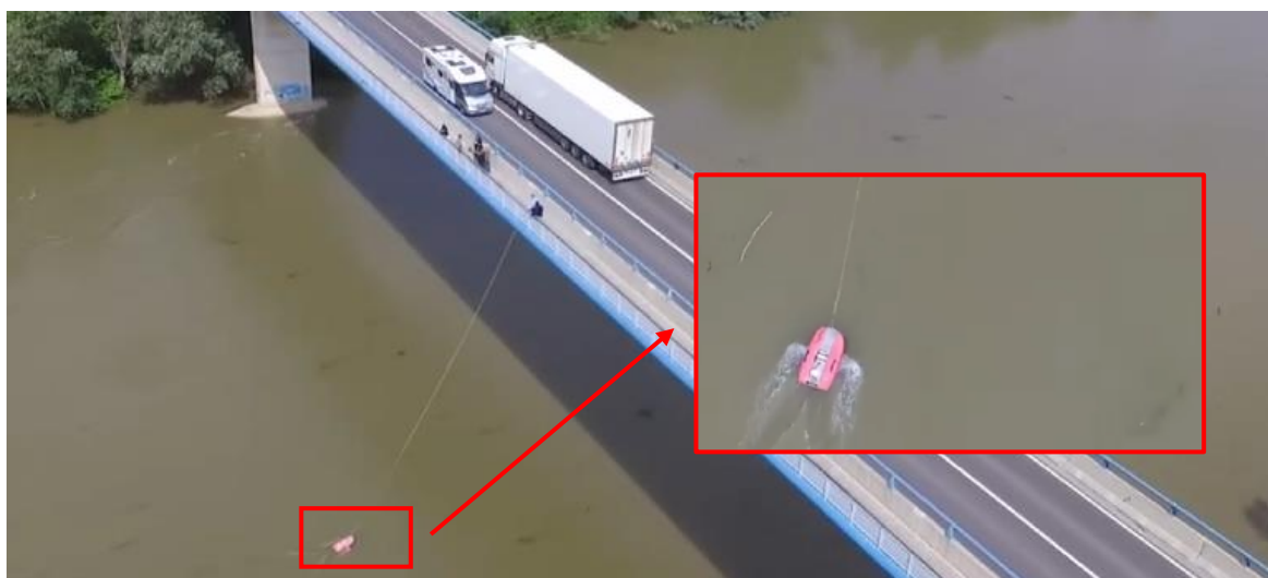
Figura 15. Equipo 5 realizando un aforo líquido en el puente de Ribarroja.
