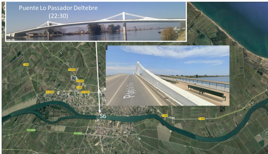
Figura 10. Sección de control S6. Puente Lo Passador de Deltebre.
