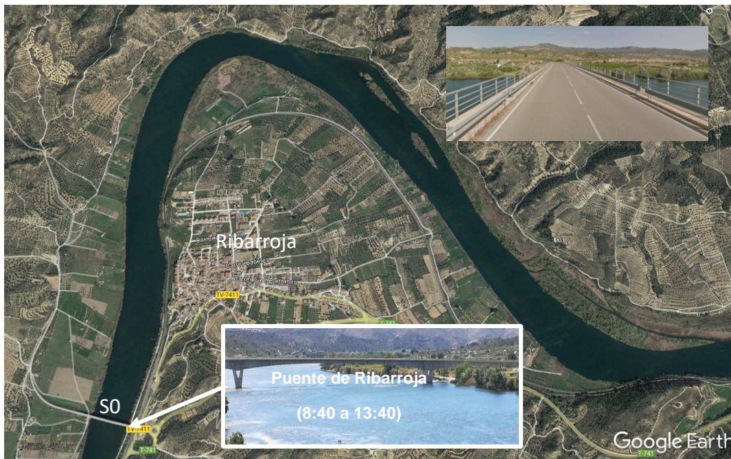
Figura 4. Sección de control S0. Puente de Ribarroja.
