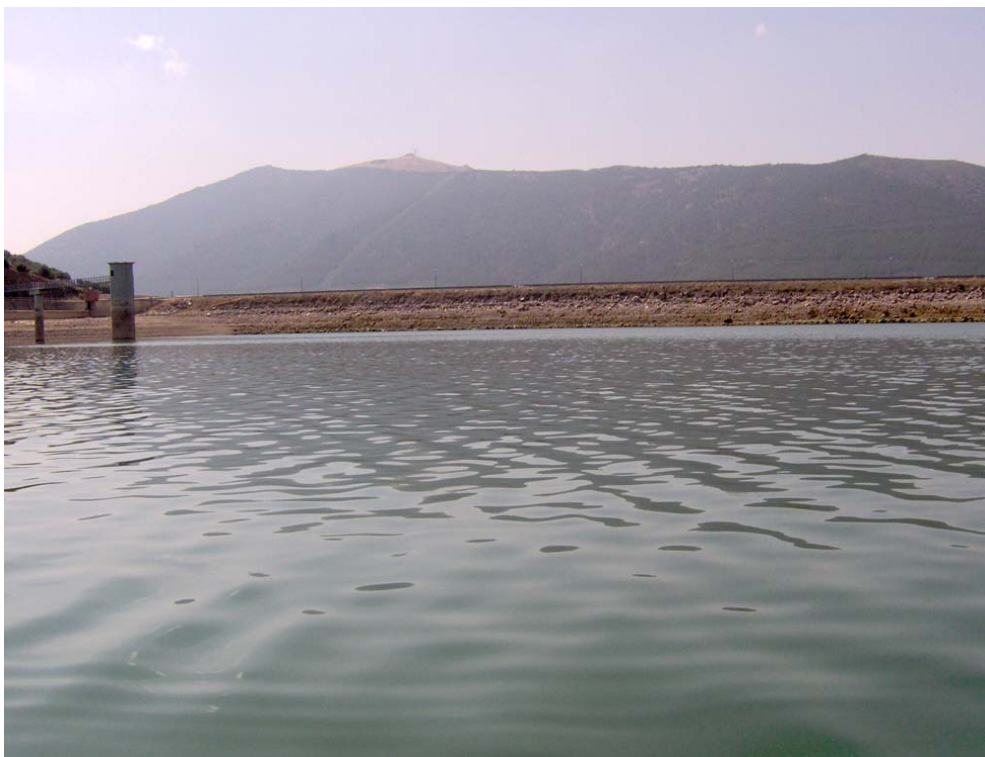
Vista de la presa desde la estación de muestreo (E1). Verano de 2005 (17/08/2005)
