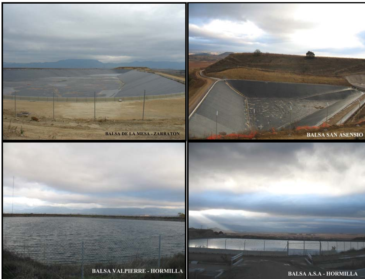
Figura 2.37: Algunas de las nuevas infraestructuras de riego construidas en el Tramo III del canal M.I. del Najerilla.
