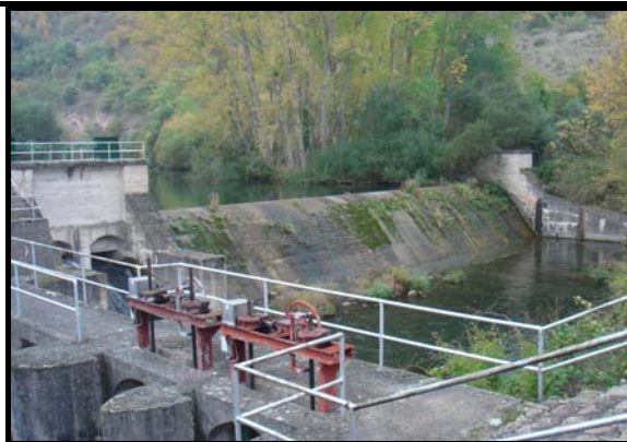
Azud de toma del canal de la MI
