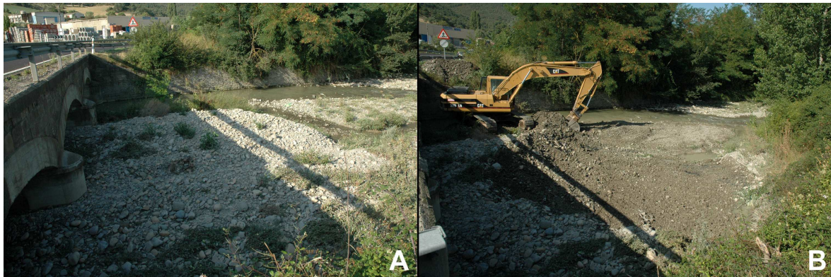
Foto 5. Estación CEMAS 2140 (Gas en Jaca). A: Parte inferior del tramo antes del inicio del dragado; B: Dragado del cauce.
