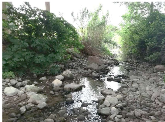
CEMAS 1282. Río Isuela en el puente de Nueno, el lecho del cauce estaba limpio.
