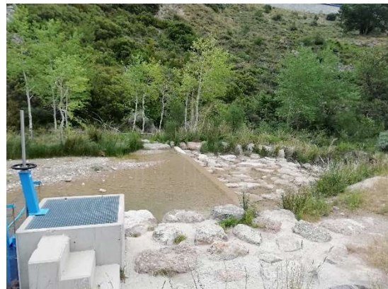
Azud de Batán, tomas de riego.
