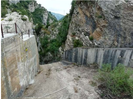
Detalle del aliviadero de la presa de Arguis.
