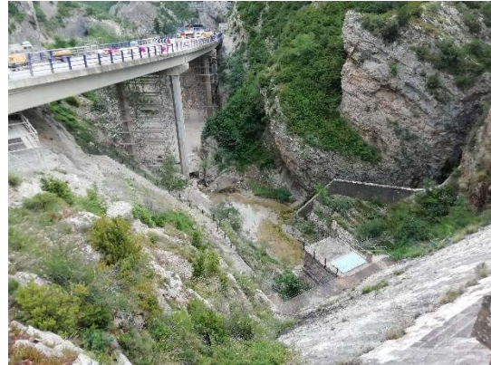
Aspecto del río Isuela, aguas abajo de la presa de Arguis, canalizado. Detalle de la presa y el aliviadero.
