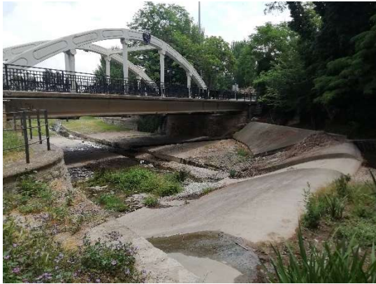
Azud del puente de San Miguel, inicio de la canalización del río.
