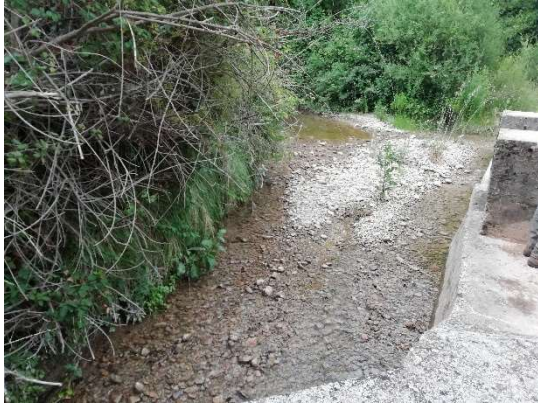
Río Isuela, aguas arriba del Azud de Bueno II.
