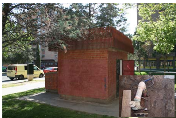
Pozo P-3 Parque Atenas y Lisboa IPA 2715-4-0292
