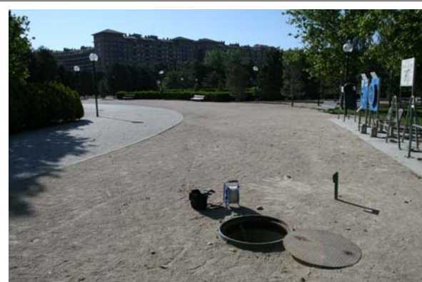
Pozo P-4 Parques Aljafería IPA 2715-4-0293
