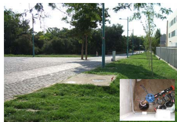
Pozo P-5 Parque Pasarela Voluntariado
