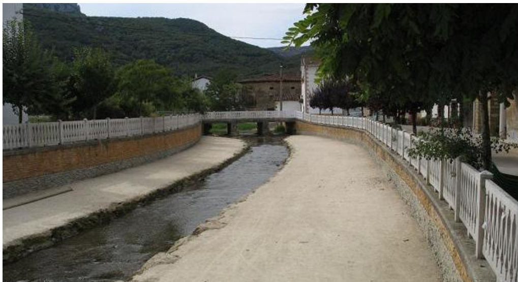
Figura 9-5. Tramo canalizado en la localidad de Marañón.
