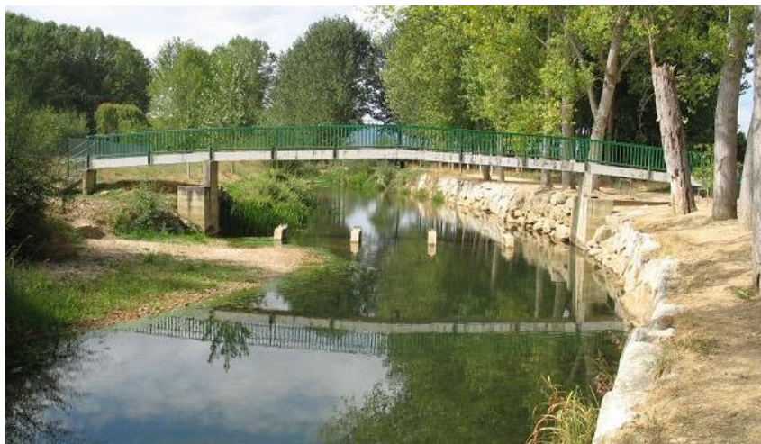
Figura 9-9. Defensas en el cauce del río Ega en torno a la localidad de Murieta.
