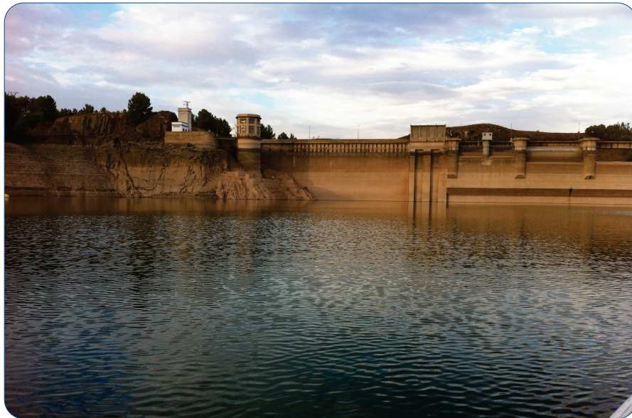
Figura 2. Vista de la presa del embalse de La Tranquera
