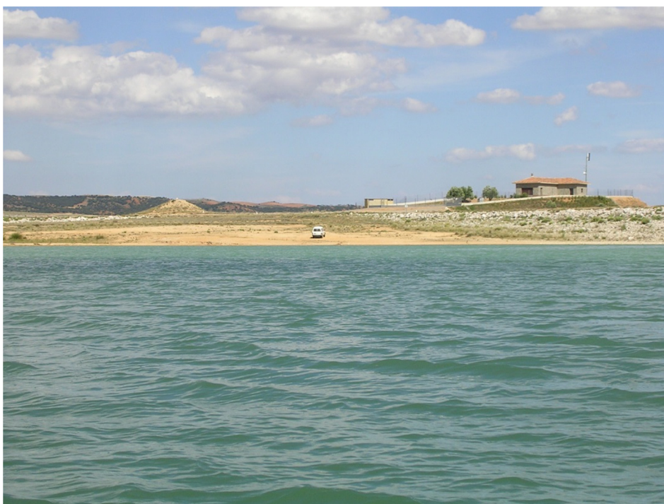
Figura 8. Vista del punto de acceso.
