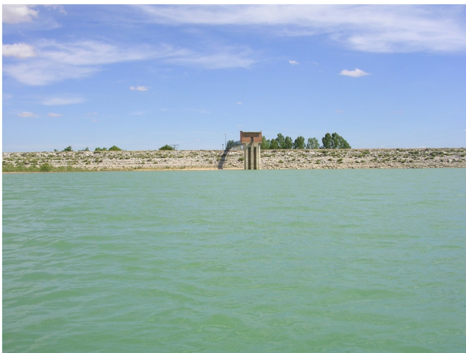
Figura 7. Vista de la presa del embalse.
