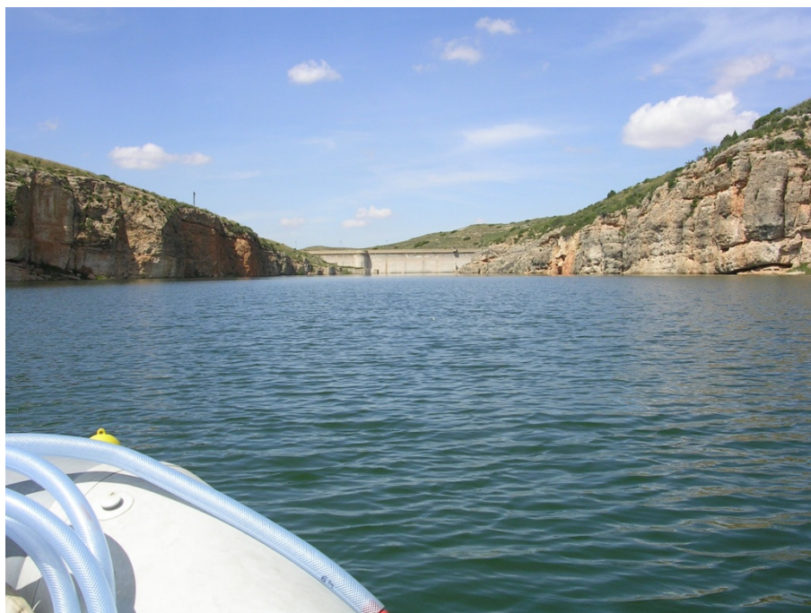
Figura 6. Vista de la presa del embalse
