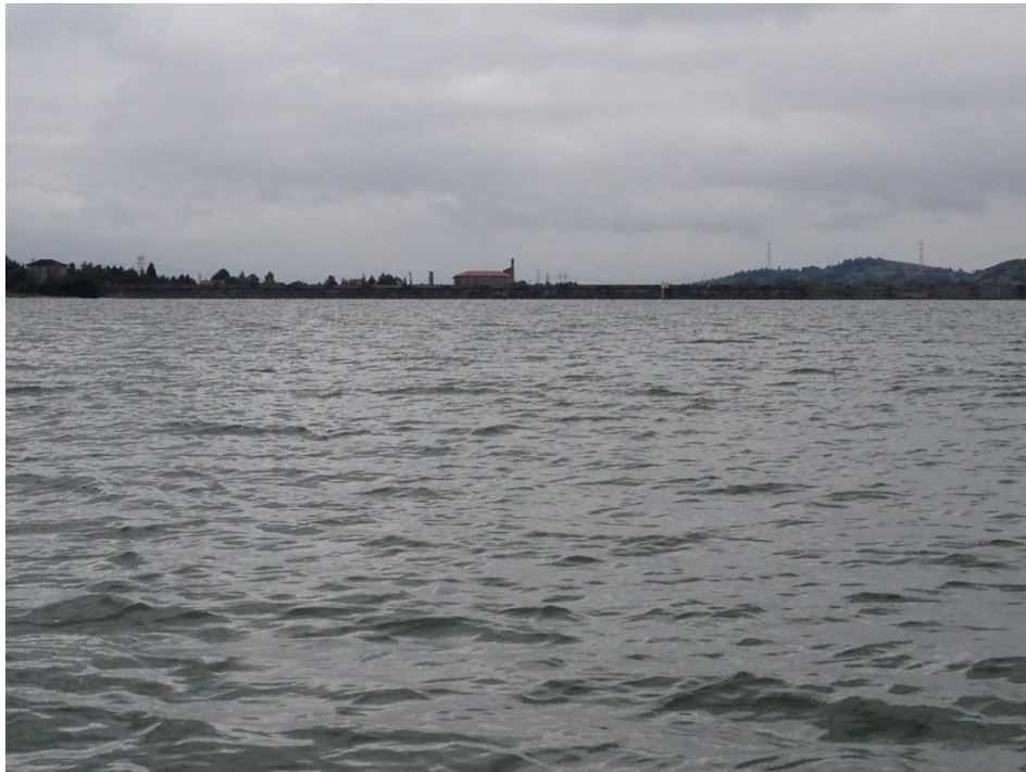
Figura 7. Vista de la presa del embalse
