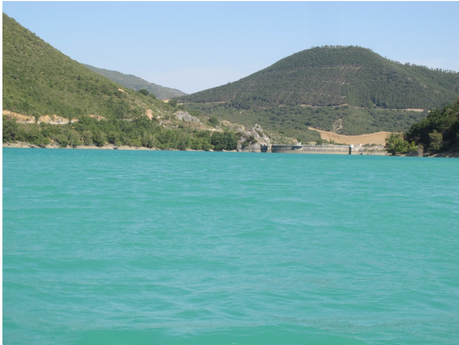
Figura 7. Vista de la presa del embalse
