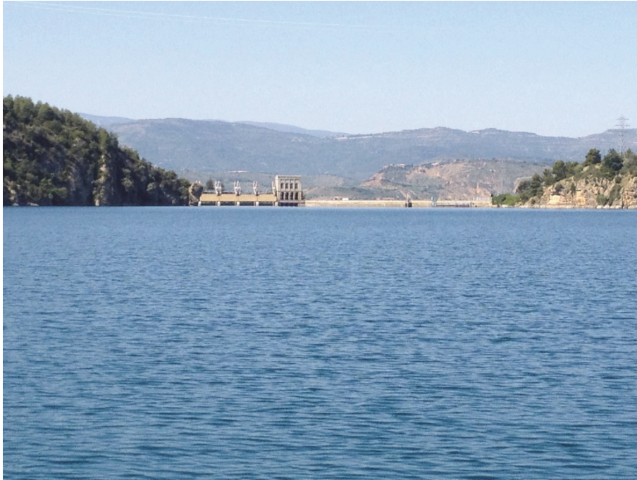
Figura 7. Vista de la presa del embalse
